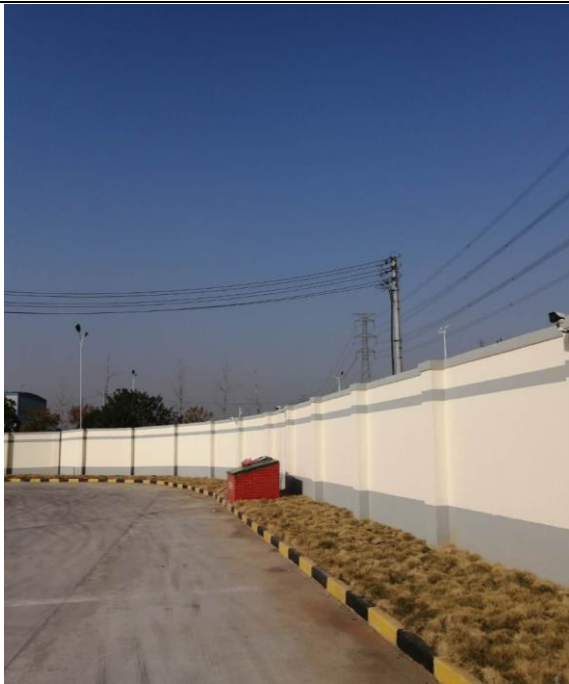
实体围墙+消防沙池
